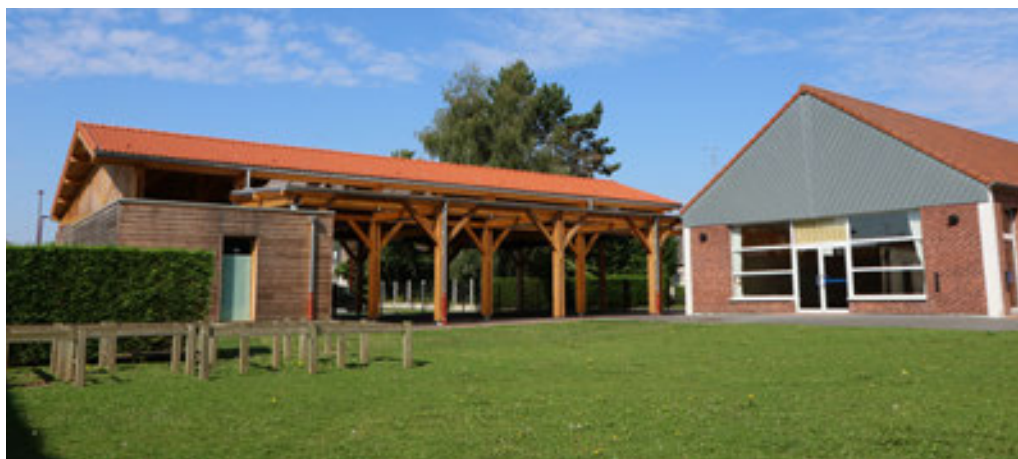
Halle de Wasnes-au-Bac
