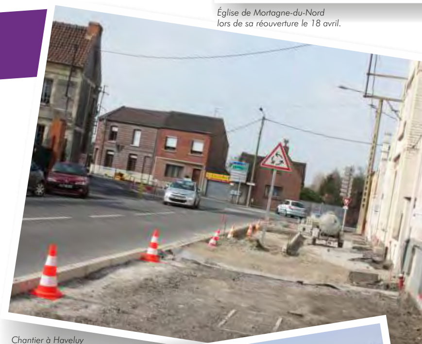
Chantier à Haveluy
