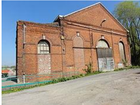
Bâtiment de la machine d'extraction de la fosse Boca des mines de Douchy.
