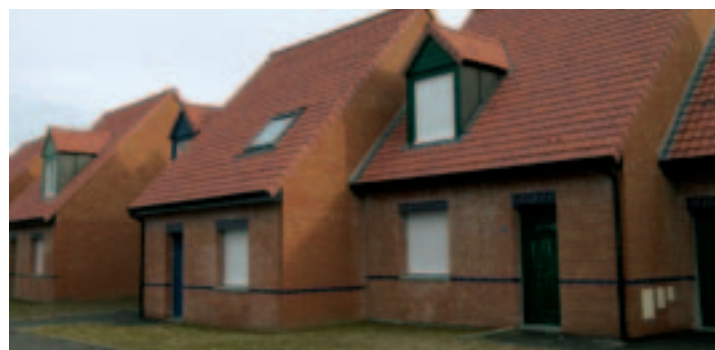
Les opérations de construction ou de rénovation, comme ici à Hasnon, sont bien éloignées de l'image terne et triste encore associée au logement social.
