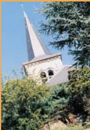
La rénovation extérieure de l'église Saint Léger, construite en briques et pierres d'Avesnes, figure parmi les projets incontournables de la commune.
