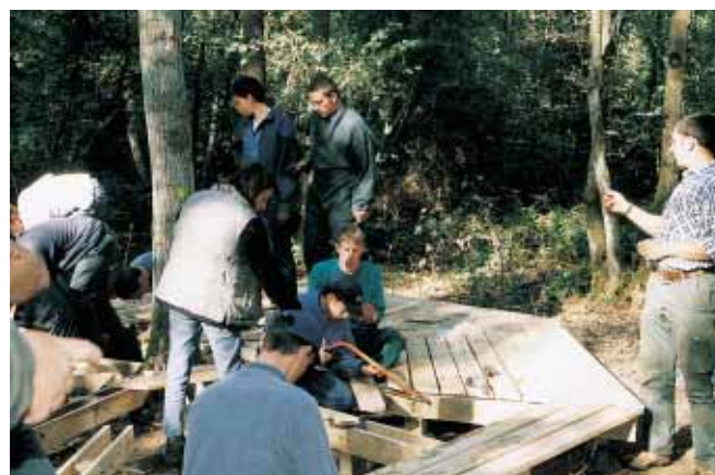
» Le plancher de l'observatoire est construit uniquement avec des outils traditionnels. Et ça avance plutôt bien.
