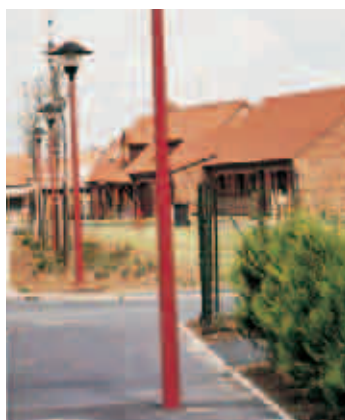
) Le lotissement communal et la maison de retraite ne suffisent pas à la demande.
