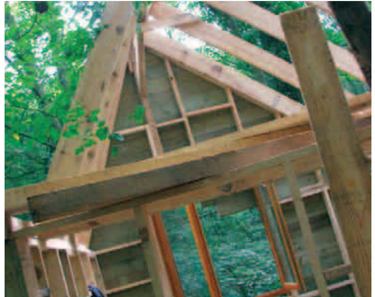
) Une maison tout confort à laquelle il ne manque que l'eau courante.
