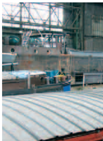
Le chantier fluvial peut recevoir plusieurs gros bâtiments simultanément.
